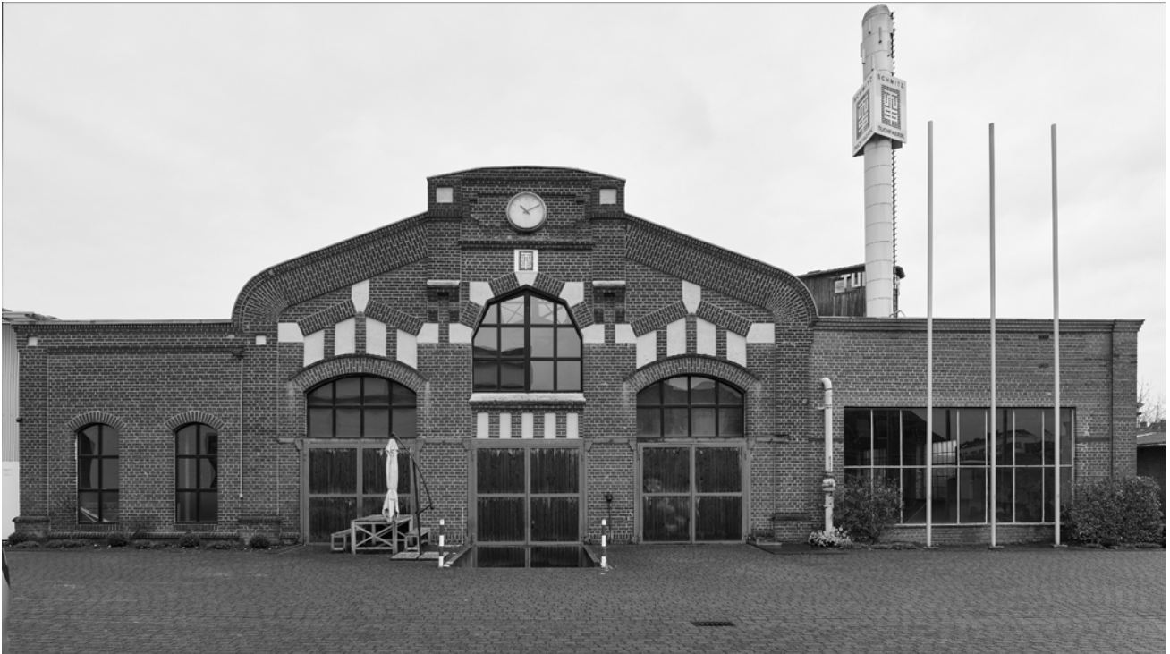
“Kesselhaus” of Tuchfabrik Willy Schmitz GmbH & Co KG, photo: Esser, Moenchengladbach, 2018
